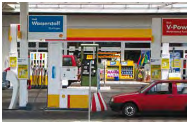
Abbildung 10: Shell-Tankstelle am Sachsendamm in Berlin, 2011
